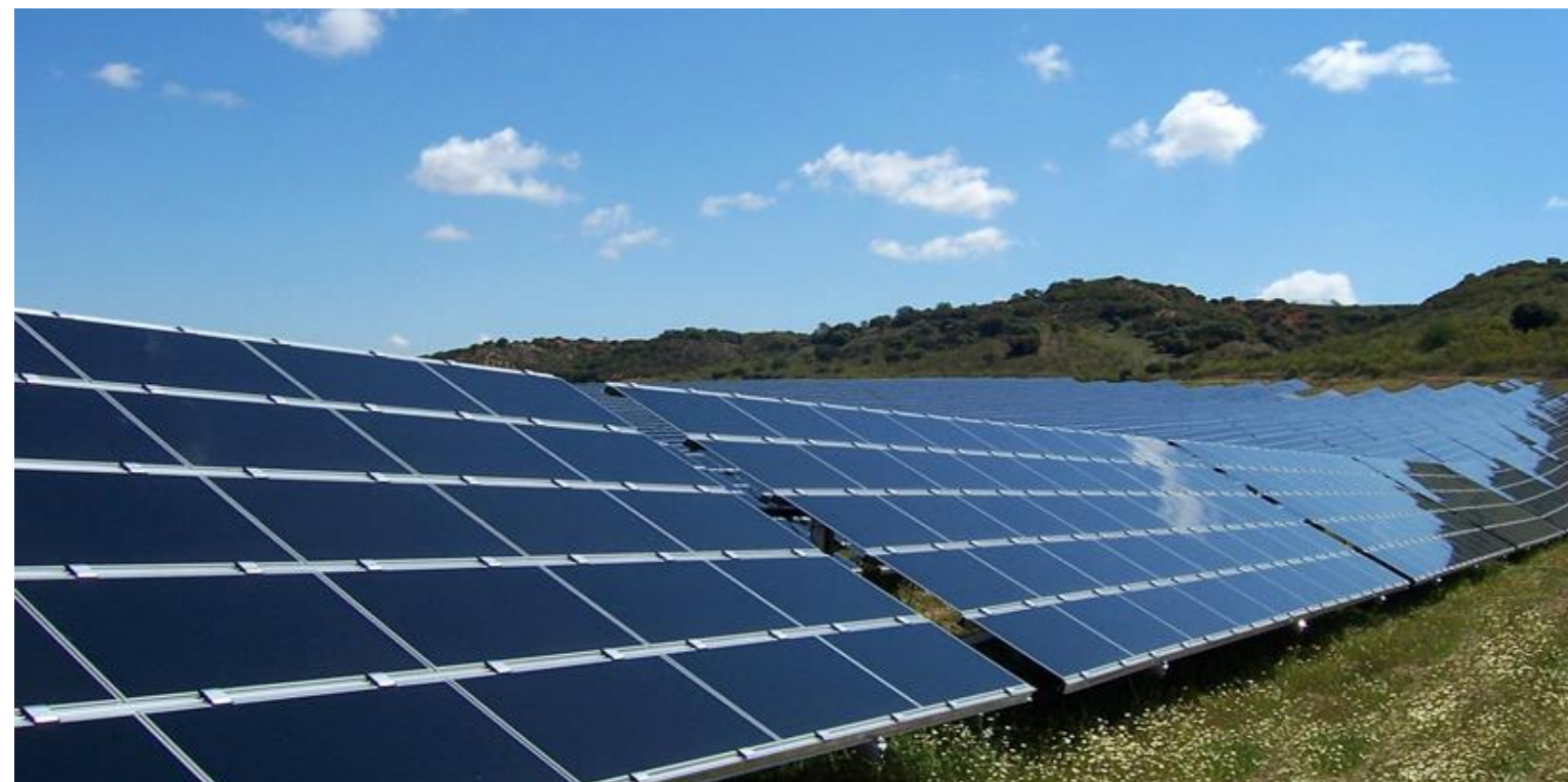
Parc photovoltaïque de Narbonne (source : EDF Renewables)
