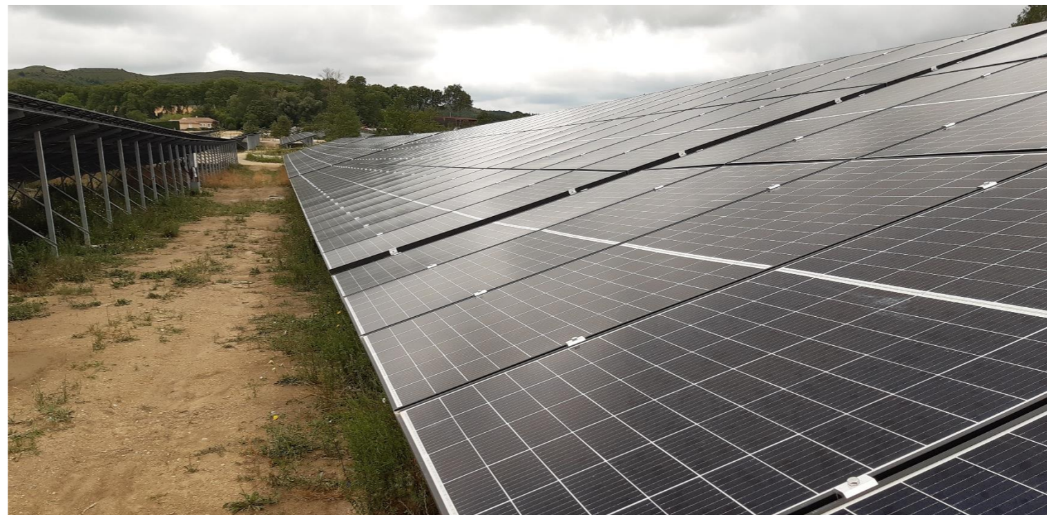
Les structures photovoltaïques s'adaptent à la topographie (source : Soler IDE)
