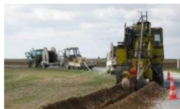
Déroulage et pose des câbles (source : EDF Renouvelables)
