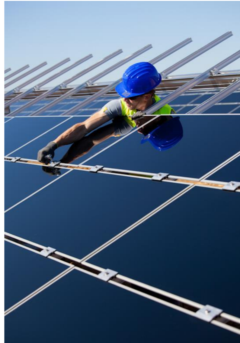
Remplacement de module (source : EDF Renewables)
